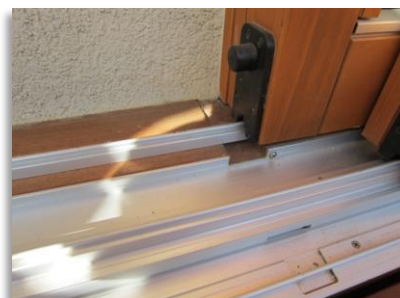
敷居、レール等、水切り加工をして雨水が抜けるようにしてあります。
