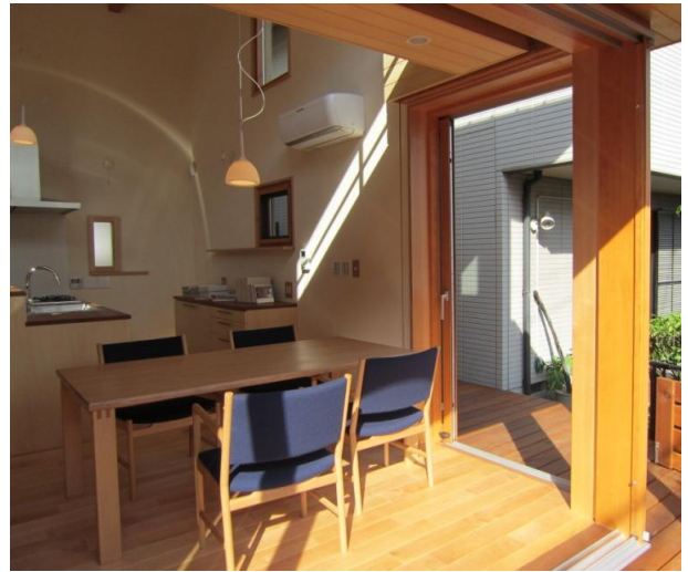
片引込戸(ヘーベシーベ構造) 2枚引込戸とは、柱を挟んで90°の位置にあり、障子を開けるととても開放感があります。
