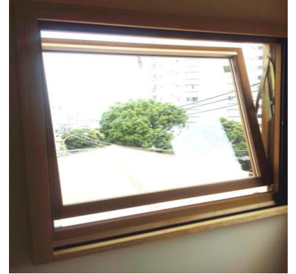
約160° 回転した状態 ※ガラスの清掃・塗装の メンテナンスも楽々行えます。
